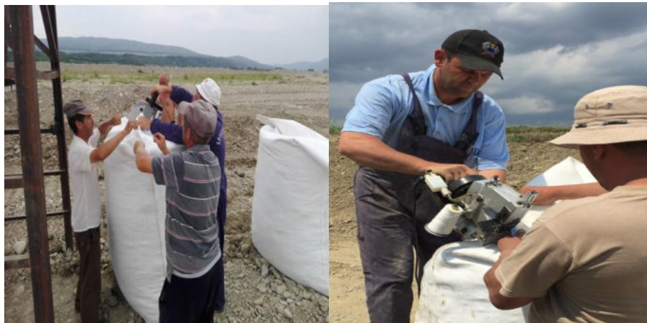
Figura 16. Operațiunea de coasere a geocontainerelor (foto autor)
