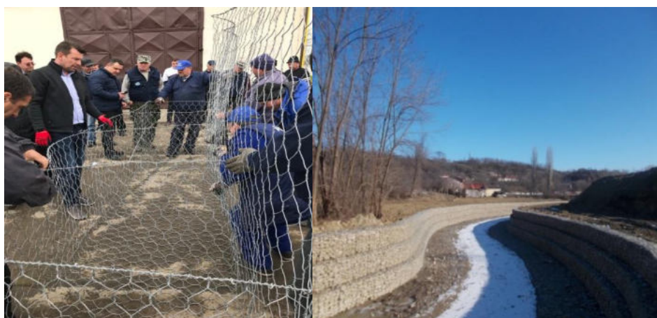
Figura 8. Asamblarea gabioanelor alternative (foto autor)
