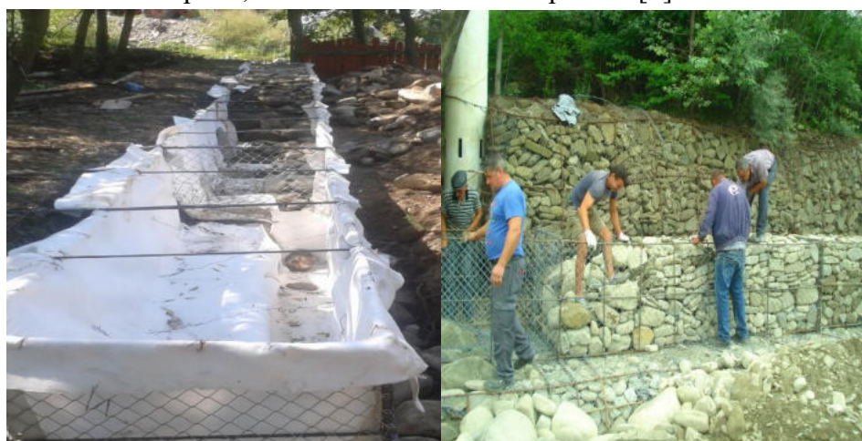
Figura 13. Umplerea gabioanelor cu piatră brută (foto autor)
