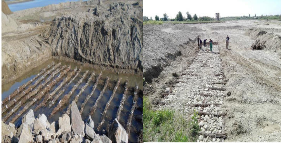
Figura 14. Pregătirea amplasamentului, saltea din fascine lestata cu anrocament (foto autor)
