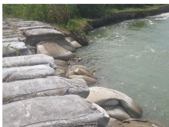
Figura 41. Degradarea lucrării de geocontainere prin deplasarea geocontainerului – lucrare transversală
