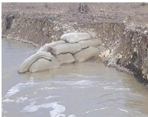
Figura 36. Degradare prin aplatizare și încovoiere
