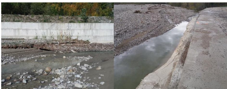
Figura 29. Degradare prin scăderea cotei talvegului a lucrărilor de gabioane acoperite cu beton cu beton (foto autor)
