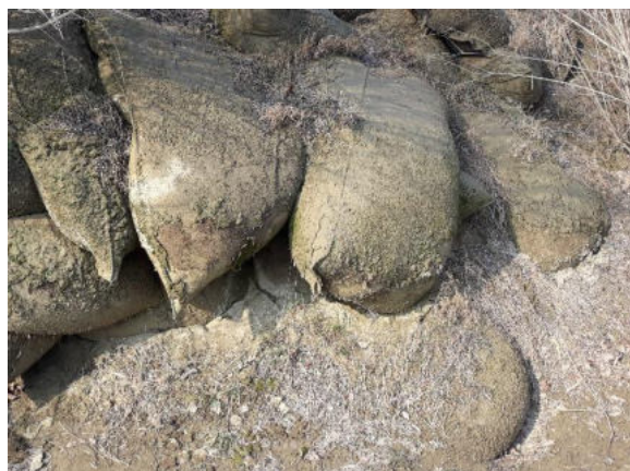
Figura 39. Degradarea lucrării de geocontainere prin scăderea cotei talvegului situație din teren (foto autor)
