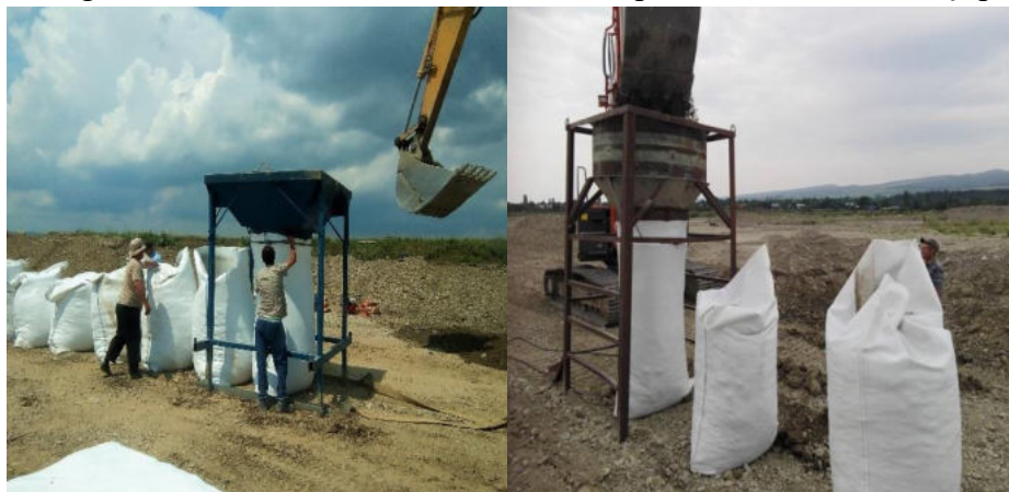
Figura 15. Operațiuni de umple a sacilor (foto autor)
