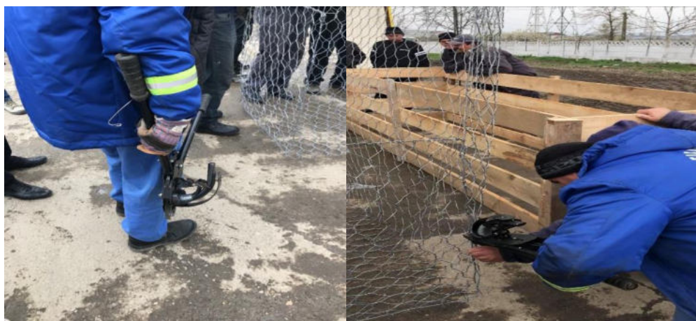
Figura 6. Prinderea capselor cu ajutorul clește manual (foto autor)
