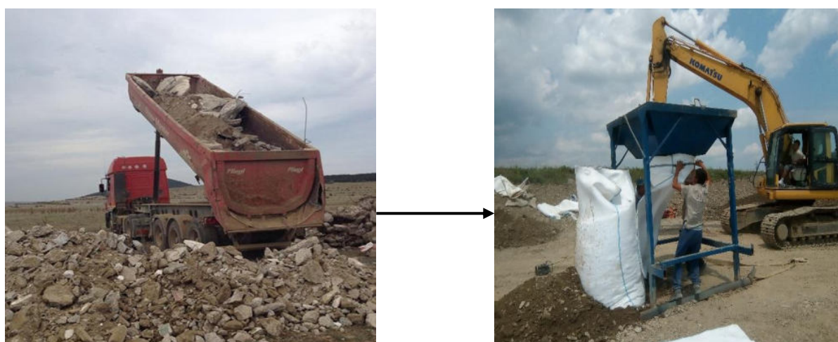
Figura 100. Utilizarea moluzului pentru umplerea geocontainerelor
