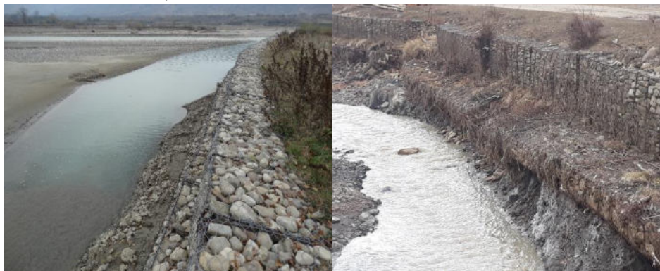
Figura 28. Degradare prin scăderea cotei talvegului a lucrărilor de gabioane simple (foto autor)
