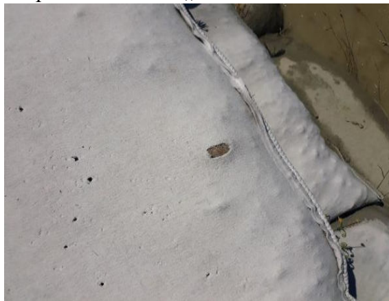
Figura 46. Degradarea provocată de obiecte colțuroase
