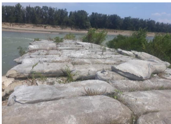
Figura 43. Degradarea prin depășirea nivelului lucrării
