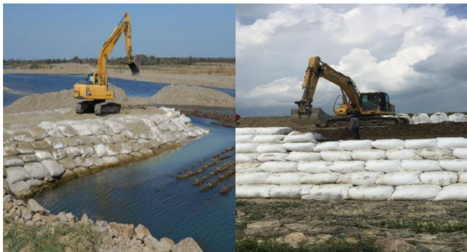
Figura 18. Amplasarea geocontainerelor (foto autor)
