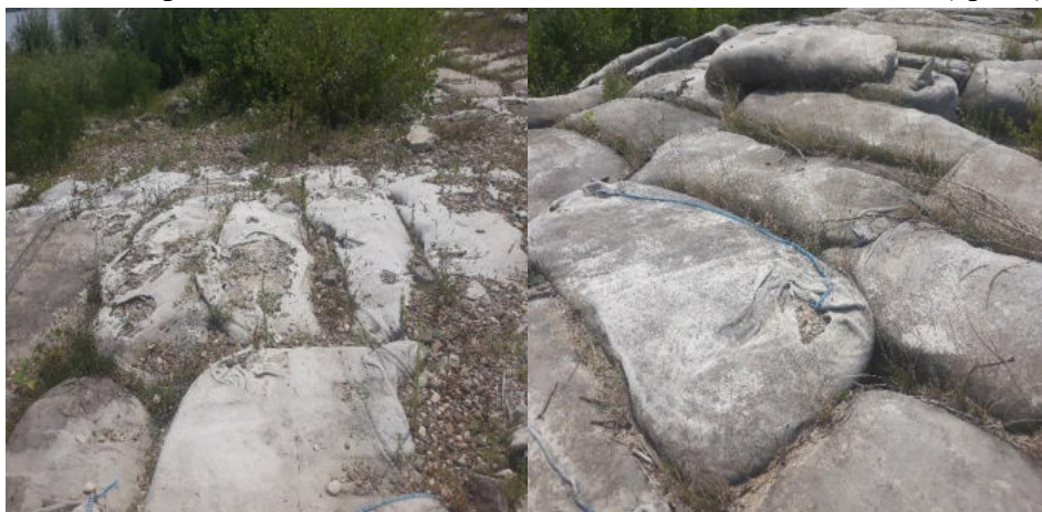
Figura 47. Degradarea provocată de transportul plutitorilor
