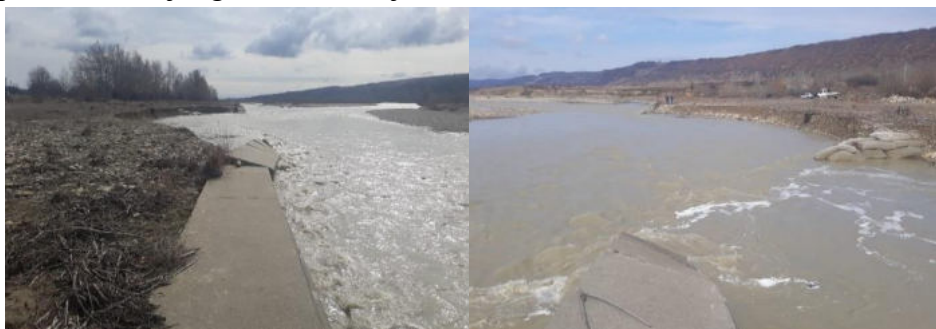
Figura 25. Lucrare din gabioane îmbrăcată cu beton răsturnată (foto autor)
