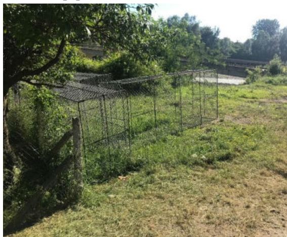
Figura 1. Gabioane clasice (foto autor)
