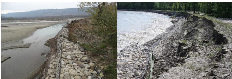
Figura 27. Lucrare din gabioane degradată prin alunecare (foto autor)
