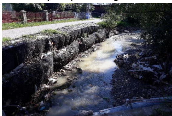
Figura 30. Degradare provenită de la execuția incorectă (foto autor)
