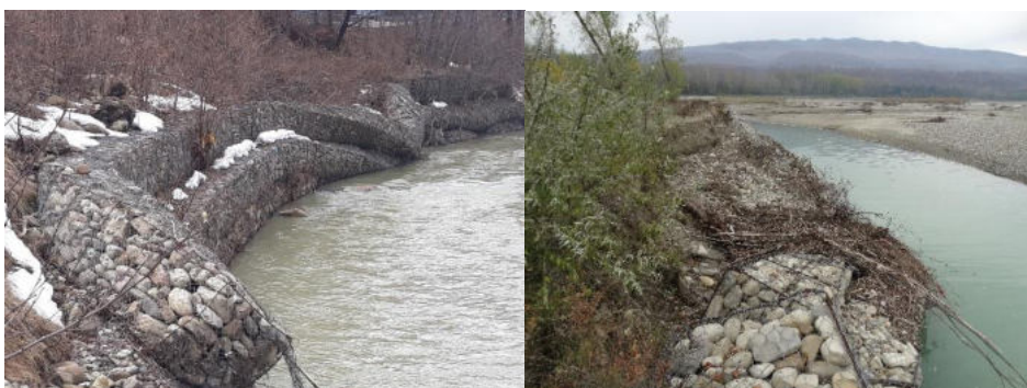
Figura 26. Lucrare din gabioane răsturnată (foto autor)
