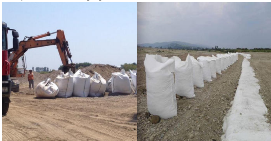
Figura 17. Pregătirea geocontainerelor pentru amplasare (foto autor)
